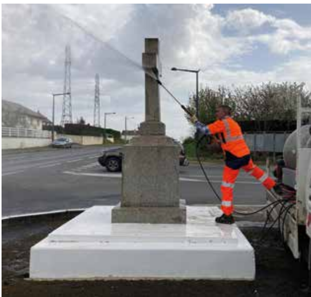
Remise en état de la croix de Noyant
